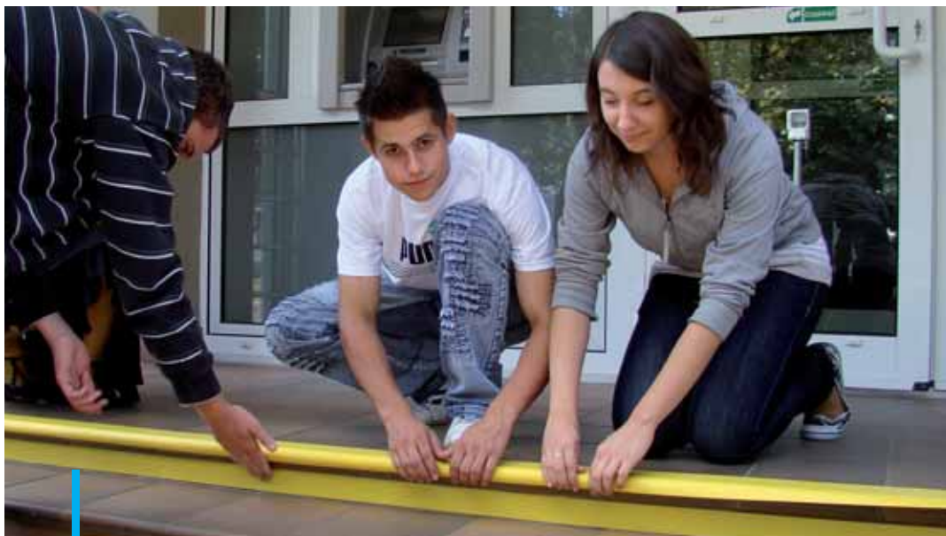
Oklejanie schodów do budynku Banku Spółdzielczego i ZUS w Hajnówce
